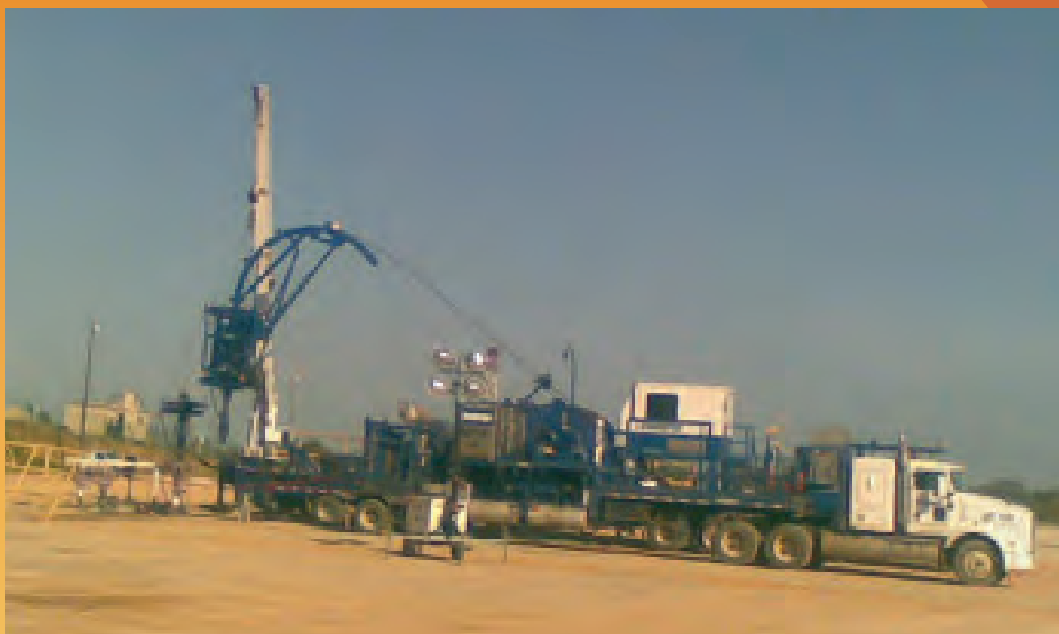
Figura 1. Instalación de TF dentro de TP pozo Rabasa 142.
