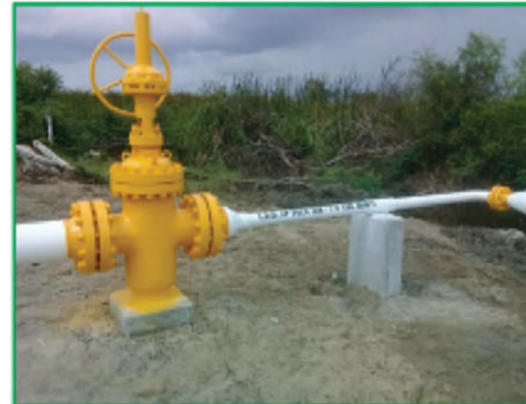
Sustitución de tubería de acero por no metálica en el campo Sen.
