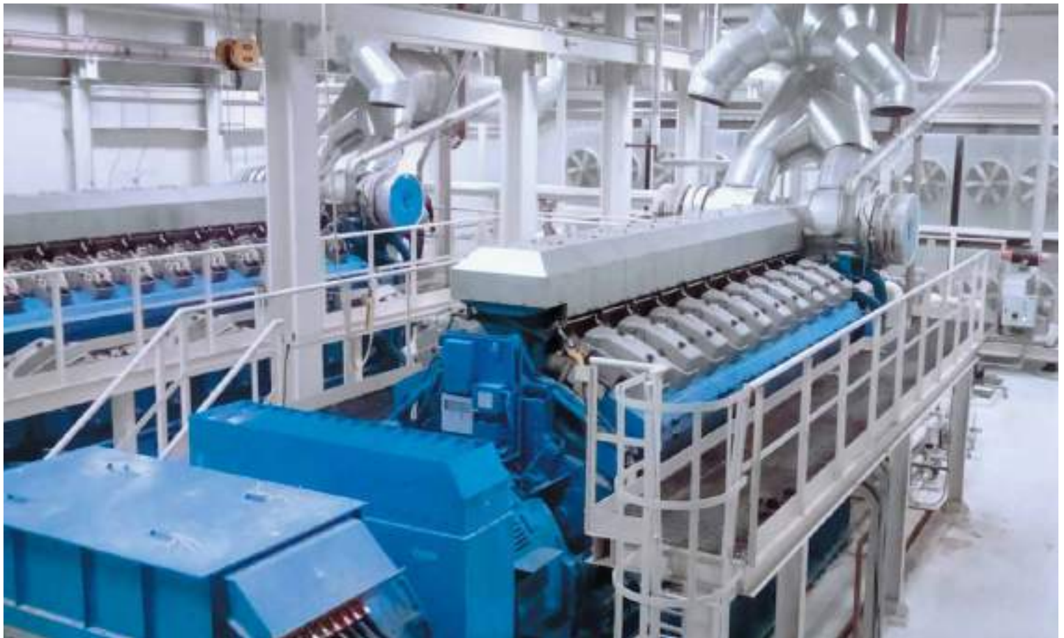
Planta de 18 MW, primer instalada en México.
