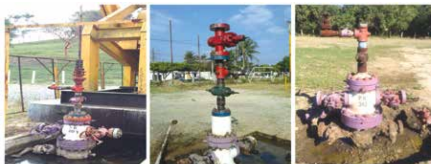
CSC BM con brida colgadora (izquierda), con brida de 2 9/16" en CBM (centro) y bola colgadora.
